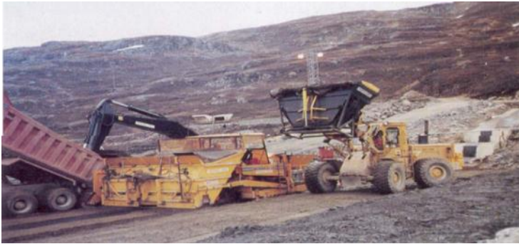
بارگیری مصالح آسفالت و فیلتر به دستگاه پخش کننده آسفالت
