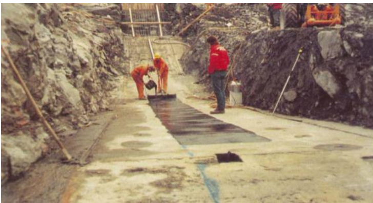
پخش نمودن ماستیک آسفالت بر روی بتن پایه
