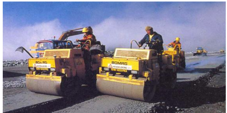
کوبیدن لایه های آسفالت و فیلتر مجاور آن بطور همزمان توسط غلطک های ارتعاشی
